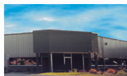
Fábrica 3 Válvulas Especiais Three River - Michigan - USA
