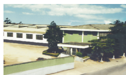
Fábrica 1 Válvulas sob encomenda Cajamar - São Paulo - Brasil
